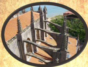
¿Cómo se denominan las estructuras con forma de arco que se sitúan en la parte exterior de las catedrales para transmitir el peso hacia los contrafuertes?
